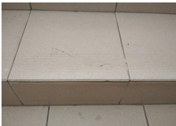
obr. /17/ Mechanicky poškozená keramická dlaždice
