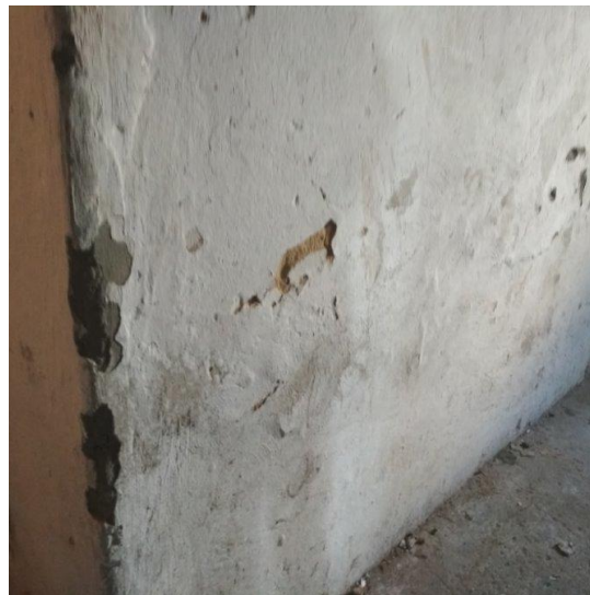
obr. /3/ Vlivem zvýšeného hydrofyzikálního namáhání ze suterénních stěn opadává omítka
