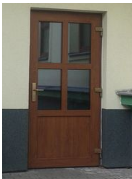
obr. /14/ Plastové vstupní dveře s izolačním dvojsklem
