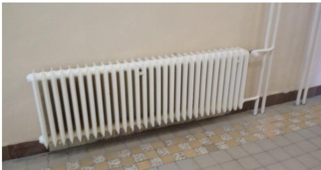
obr. /49/ Původní ocelové článkové otopné těleso obr. /50/ Nové ocelové deskové otopné těleso
