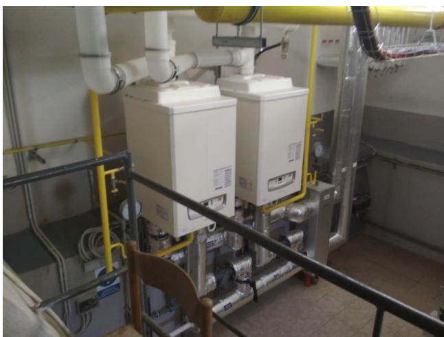
obr. /51/ Zdrojem vytápění objektu je plynový kotel
