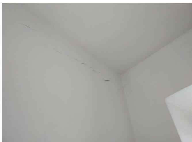
obr. /8/ Vodorovná trhlina v blízkosti uložení stropní konstrukce
