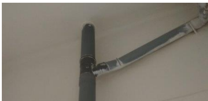
obr. /41/ Odpadní potrubí je po rekonstrukci vedeno v plastových trubkách
