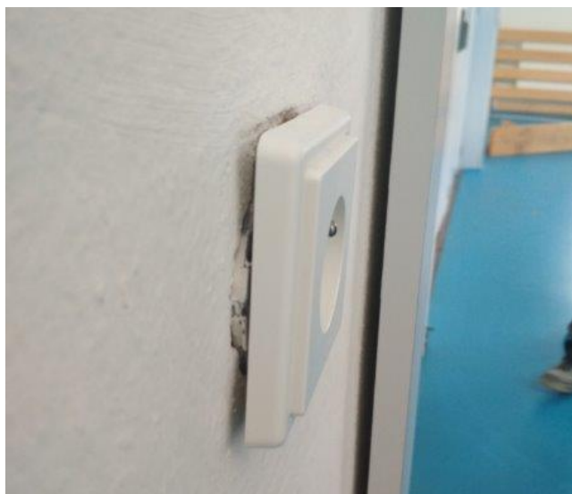
obr. /47/ Elektrická zásuvka umístěná v tělocvičně přístavby – uvolněný kryt
