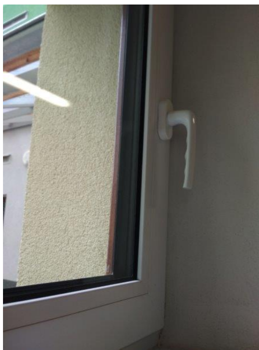
obr. /12/ Pohled na okenní výplň s izolačním trojsklem ze strany interiéru
