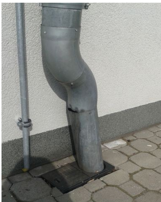
obr. /55/ Netěsnost ve styku částí střešních svodů – jihovýchodní část fasády přístavby
