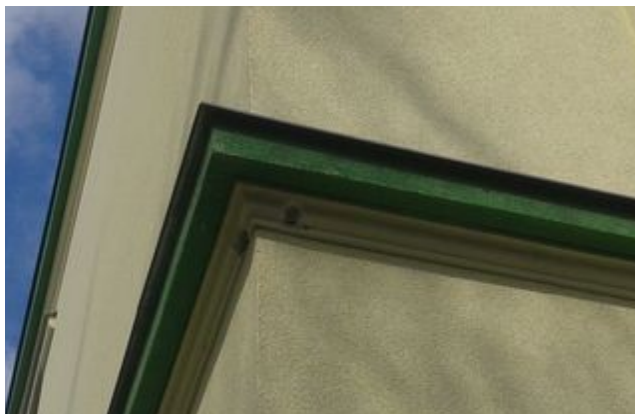
obr. /37/ Vyklované díry v zateplovacím systému fasády – jižní roh původní části objektu
