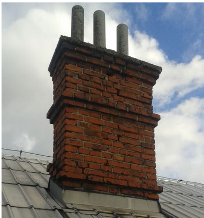
obr. /19/ Pohled na komínové těleso vyzděné z cihel plných pálených
