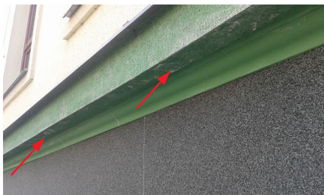
obr. /35/ Stopy zatékání do fasády – pravděpodobně z důvodu vadného napojení oplechování římsy na fasádu
