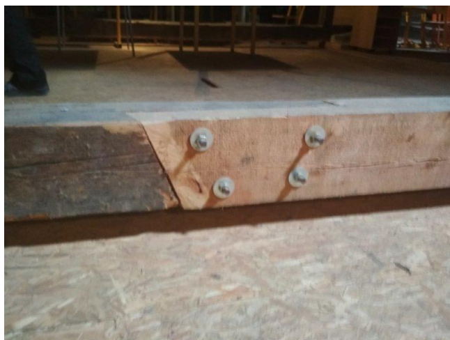
obr. /23/ Částečně vyměněný vaznicový trám krovu
