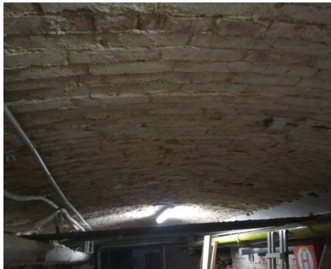
obr. /10/ V suterénu byly z klenby oklepány stávající omítky – dochází ke sprašování povrchu a riziku vypadávání malty ze spár mezi cihlami
