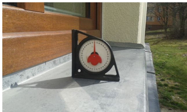
obr. /27/ Sklon okenního parapetu roven 1° směrem od fasády objektu
