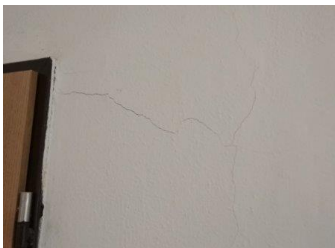
obr. /7/ Trhlina v blízkosti dveřního otvoru
