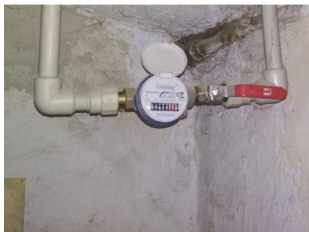
obr. /44/ V místě vodoměru je vodovodní potrubí po rekonstrukci vedeno v plastu
