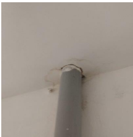
obr. /4/ V místě prostupu odpadního potrubí přes stropní konstrukci vznikají vlhké mapy
