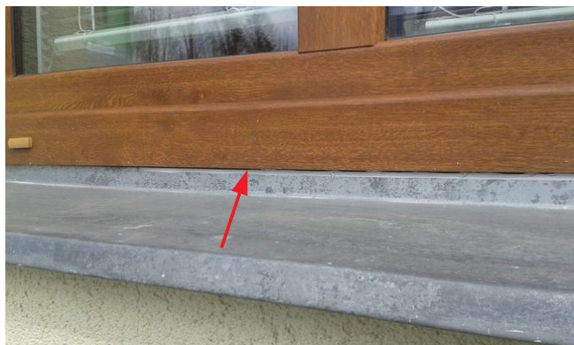
obr. /29/ Uvolněný parapetní plech – zadní čelo není zasunuto do drážky okenního profilu
