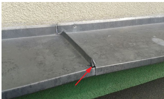
obr. /31/ Poškozené čelo stojaté drážky napojení oplechování římsy soklu původní části objektu
