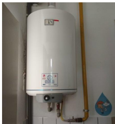
obr. /52/ Zásobníkový ohřívač teplé vody
