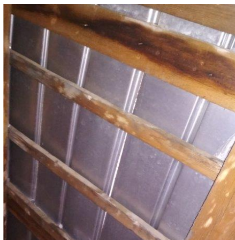
obr. /24/ Plechová krytina původní části objektu školy je vynášena pomocí dřevěných latí
