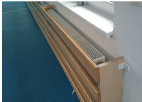
obr. /49/ Původní ocelové článkové otopné těleso obr. /50/ Nové ocelové deskové otopné těleso
