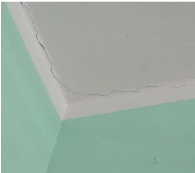
obr. /9/ Trhlina v místě styku stěny a stropní konstrukce
