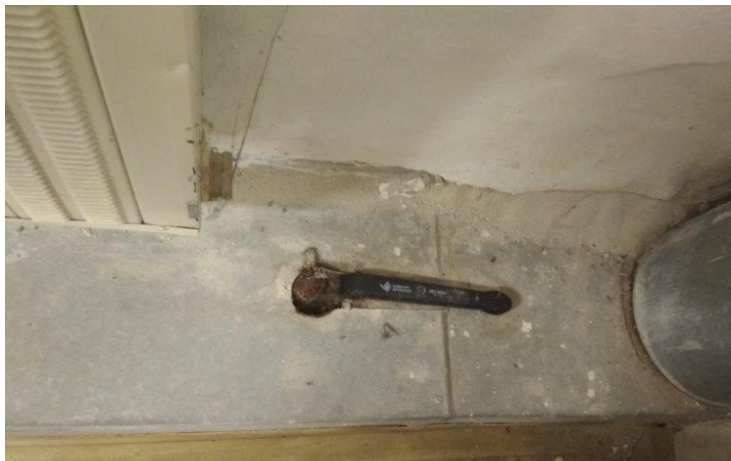
obr. /58/ Páková armatura hlavního uzávěru vody je značně zdegradovaná
