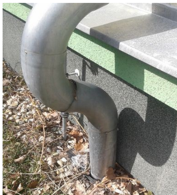
obr. /56/ Netěsné spoje svodného potrubí a zahlcení biologickým spadem
