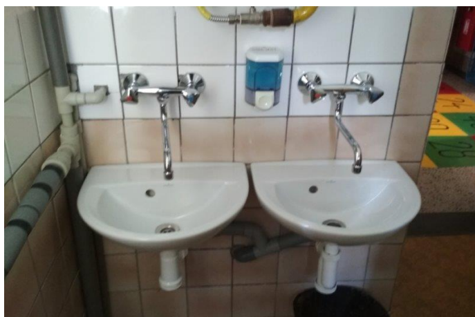
obr. /43/ Nástěnné otočné výtokové armatury
