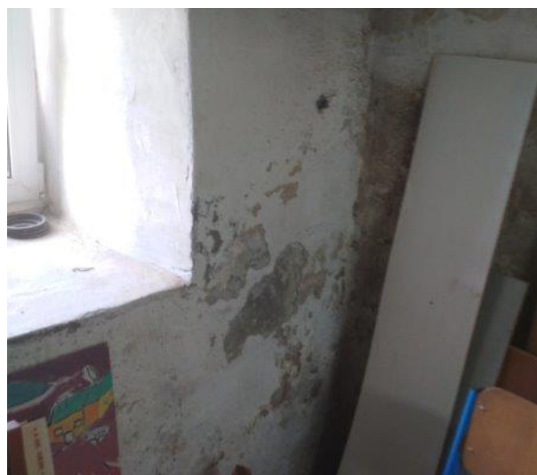
obr. /5/ Na omítce suterénních stěn se nacházejí vlhké mapy
