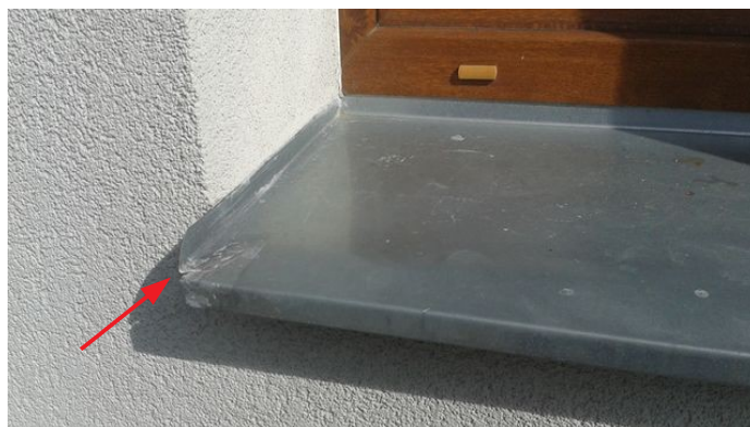
obr. /32/ Poškozený parapet v čelním ohybu – jihozápadní strana přístavby objektu
