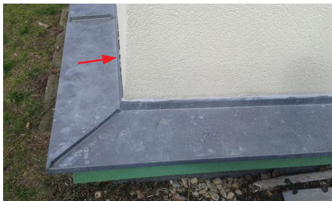
obr. /33/ Netěsnosti ve vadném napojení oplechování římsy soklu na fasádu - jihozápadní strana původní budovy
