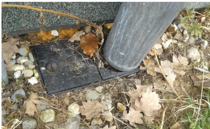
obr. /53/ Vadné napojení svodného potrubí do lapače střešních splavenin
