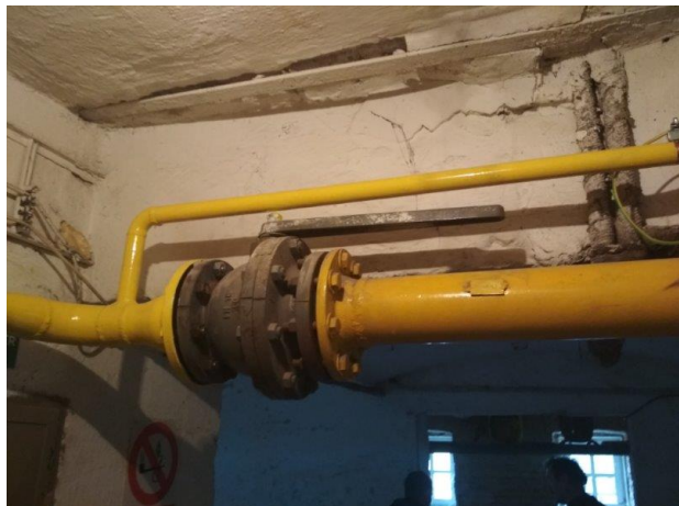
obr. /57/ Redukce plynového potrubí
