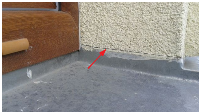
obr. /30/ Trhlina ve styku bočního čela parapetu a ostění fasády
