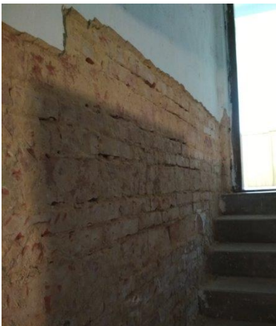
obr. /6/ Vnitřní omítky suterénu jsou oklepaný
