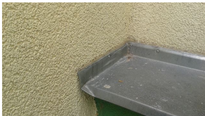
obr. /28/ Napojení oplechování soklu - styk těsněn pomocí tmele
