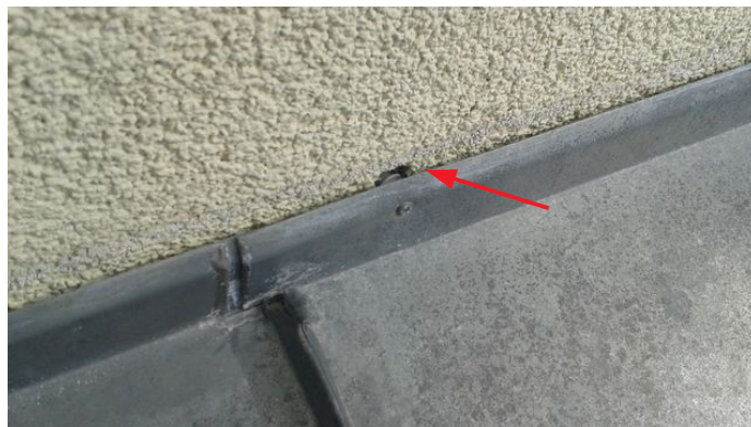
obr. /34/ Netěsnosti ve vadném napojení oplechování římsy soklu na fasádu a uvolněný kotevní prvek
